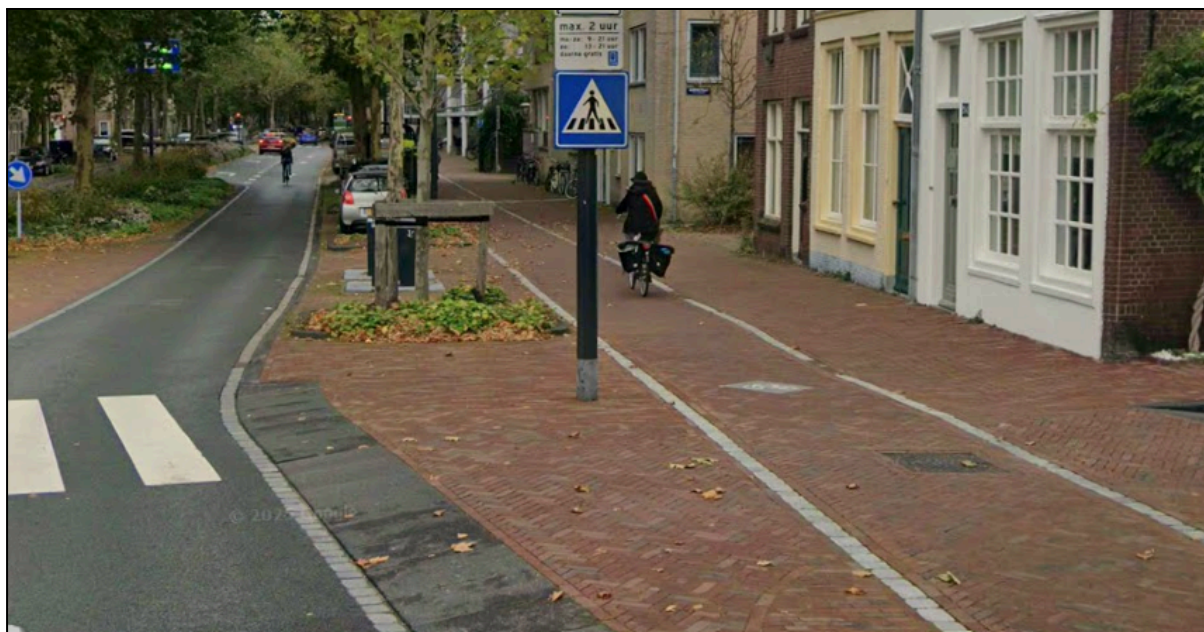
Figuur 42: verharding vrijliggend fietspad Langegracht.
